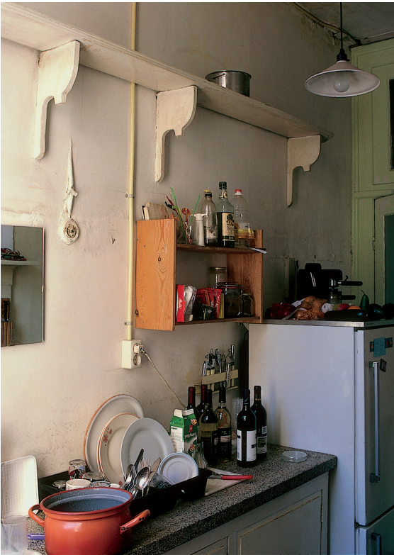
Leak , 1996, Stadhouderskade 112, Amsterdam
